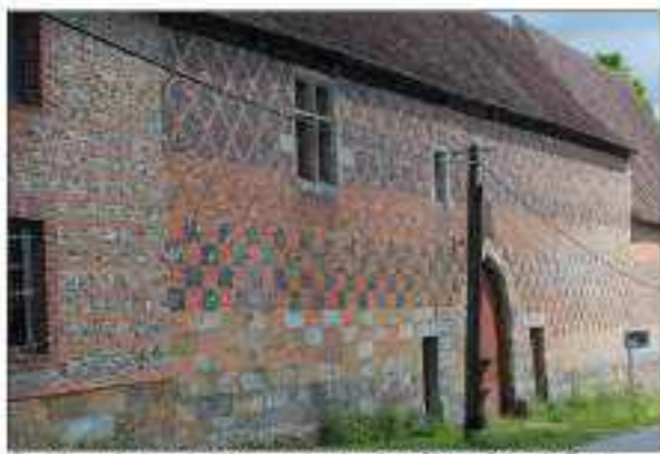
Façade en damier de briques et de silex à la Chapelle-Dieu-du-Haut.
